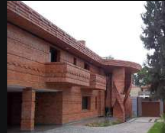
Proyecto Construcción Vivienda unifamiliar
