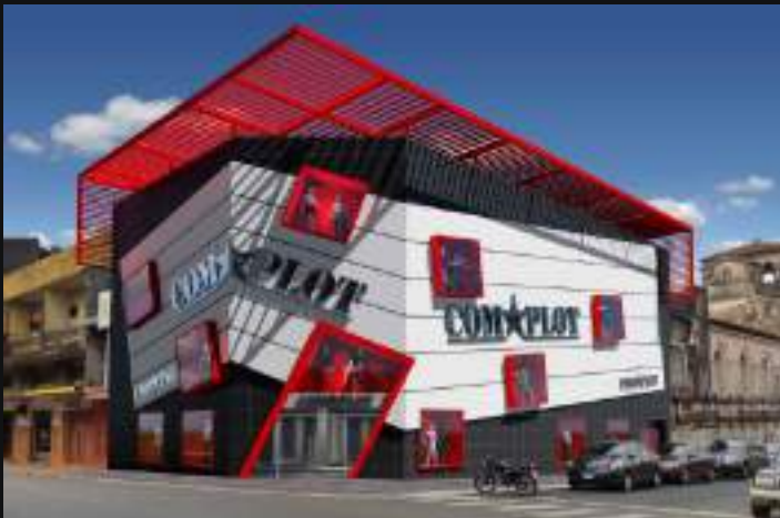
Proyecto Construcción Edificio comercial
