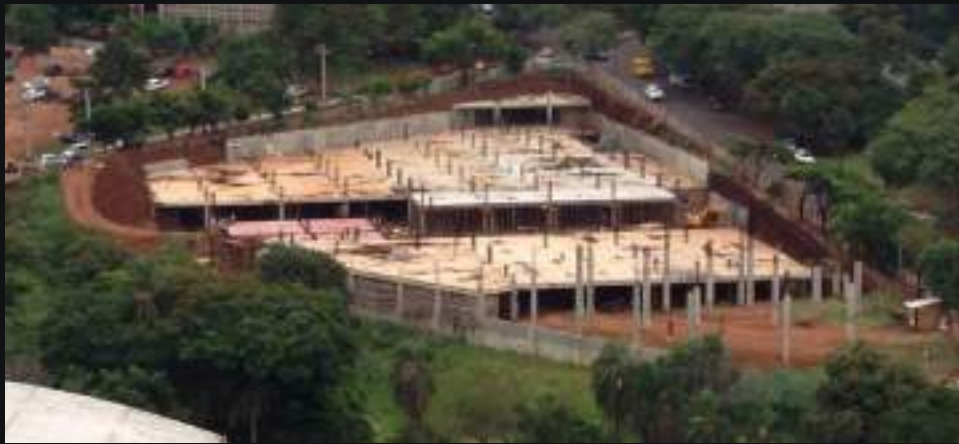
Proyecto Construcción de estructura Shopping Salemma C.D.E.
