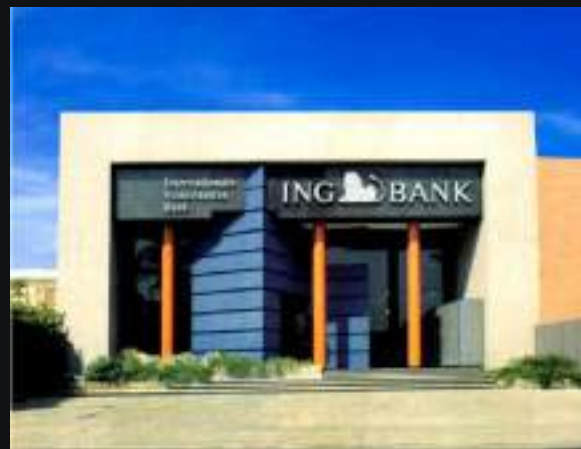
Proyecto Construcción ING Bank
