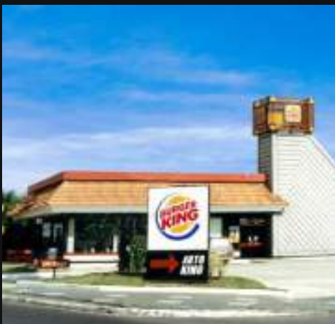
Proyecto Construcción BK Avda. España
