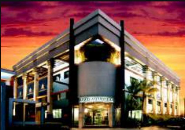
Proyecto Construcción Banco Amambay S.A.
