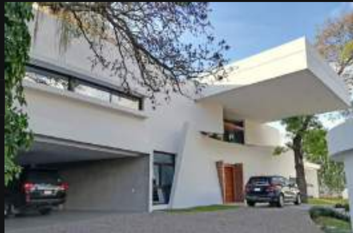
Proyecto Construcción Vivienda Unifamiliar
